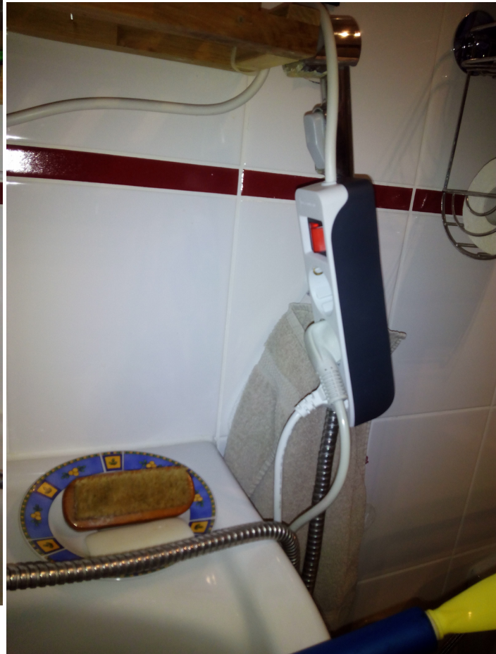
Schaubild 1: Abzweigdose einfach neben die Handbrause geklebt. Hält kein Stunde.
